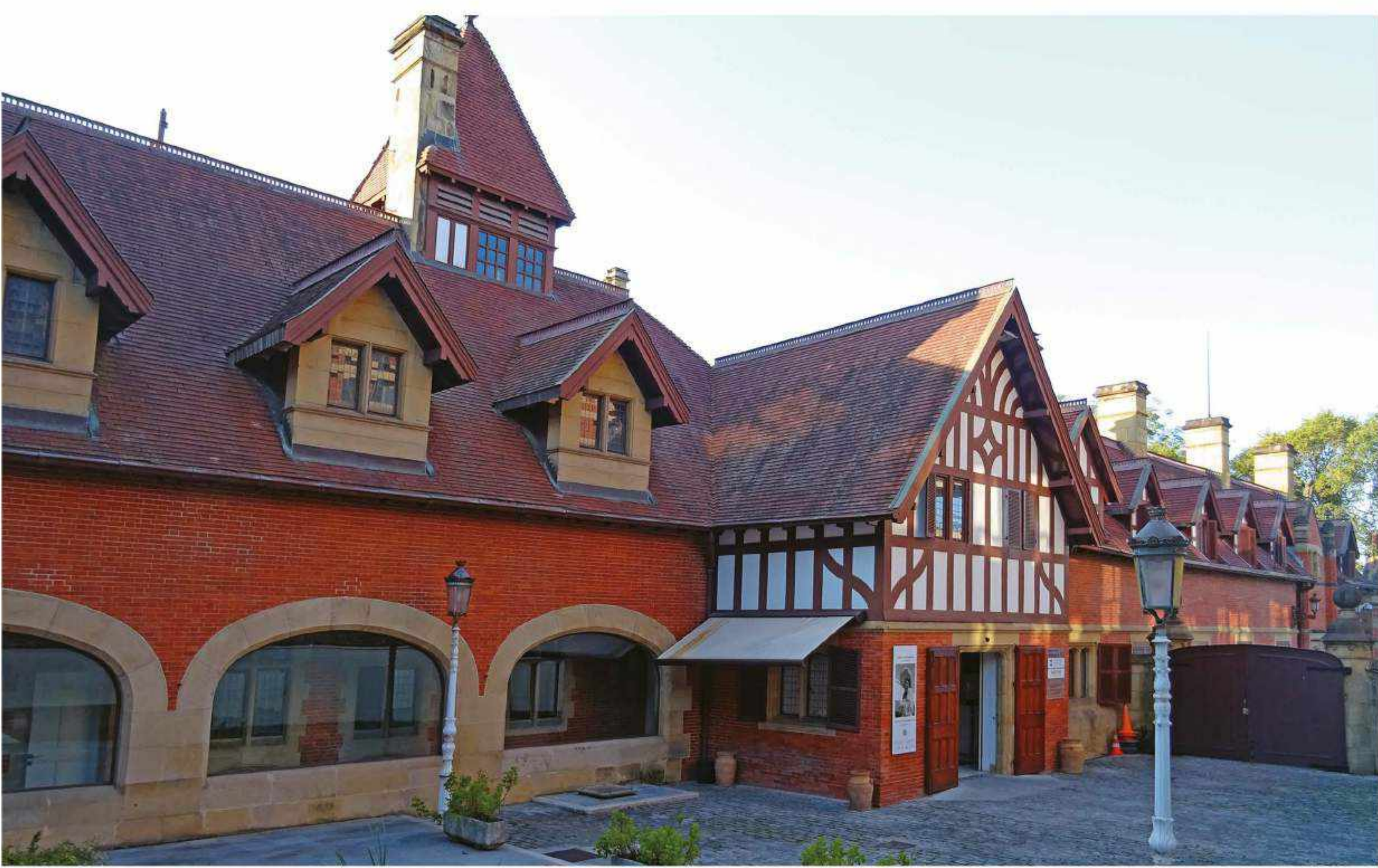
Zerbitzuen etxea. Casa de Servicios. Le Pavillon des Services. Services House.
